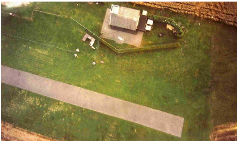
Bild 43: Für die neue Start- und Landebahn aus Verbundsteinen wurde ein solides Fundament gelegt. Sie ist bis heute absolut einwandfrei „in Form“ geblieben
