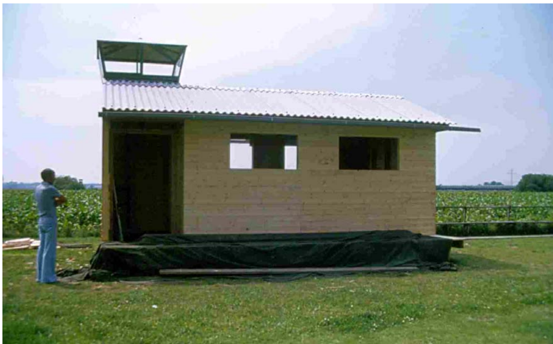
Bild 17: Nur die Fenster fehlen noch - Willi Fuchs begutachtet die geleistete Arbeit
