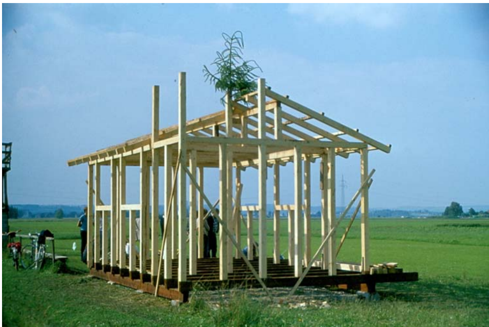
Bild 14: Das Grundgerüst der Hütte steht
