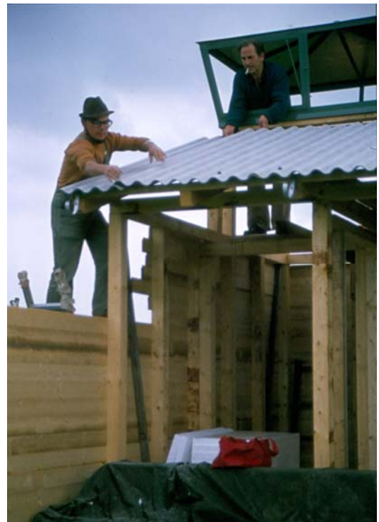
Bild 16: W.Schaal u. H.Bühler beim Dachaufbau
